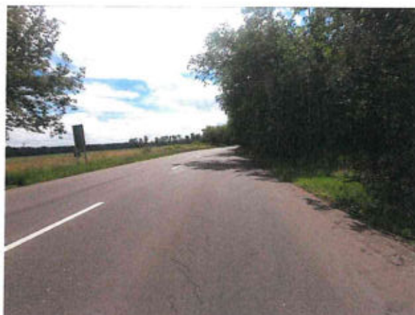
Ztráta makrotextury, mozaikové trhliny
