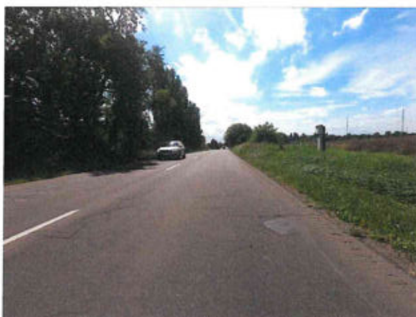
Ztráta makrotextury, vysprávka, mozaikové trhliny
