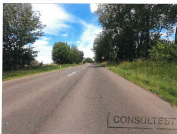
Ztráta makrotextury, mozaikové trhliny
