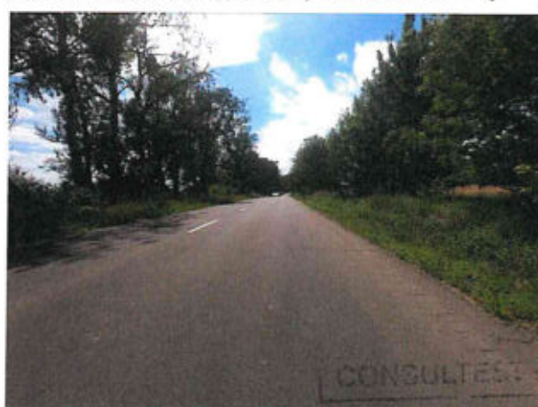
Ztráta makrotextury, vyjeté koleje, příčná trhlinka
