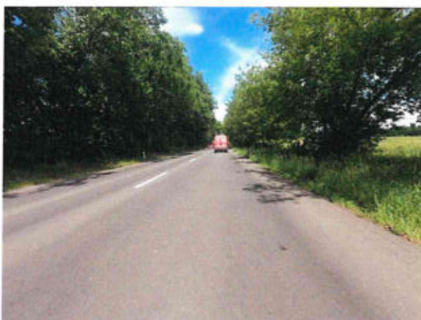
Ztráta makrotextury, vyjeté koleje, olamování okraje
