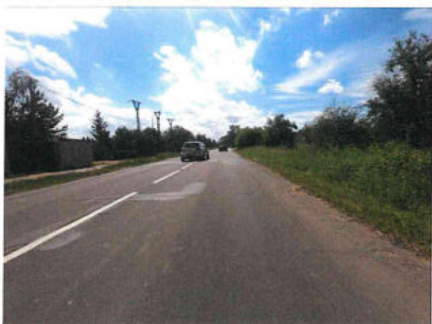
Ztráta makrotextury, vyjeté koleje, příčné trhliny, vysprávky
