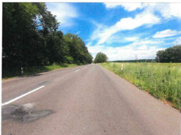
Ztráta makrotextury, vysprávka, vyjeté koleje
