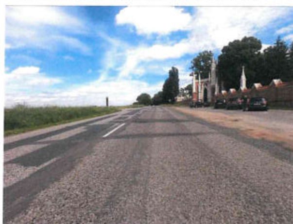
Ztráta mikrotextury, vysprávký, příčné trhliny
