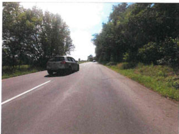
Ztráta makrotextury, vyjeté koleje, příčná trhlinka
