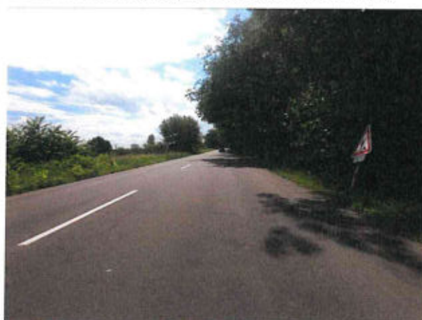
Ztráta makrotextury, vyjeté koleje, mozaikové trhliny
