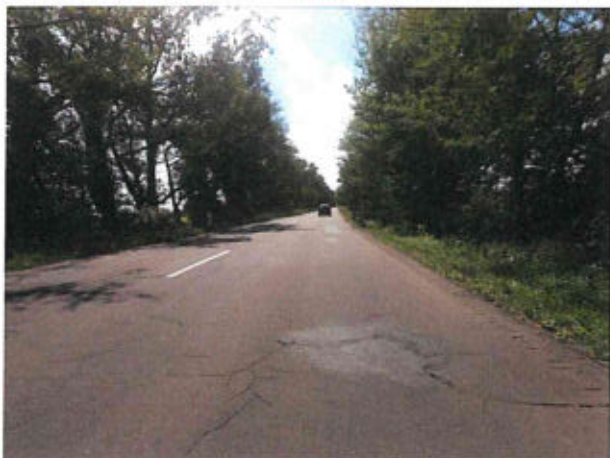
Ztráta makrotextury, mozaikové trhliny
