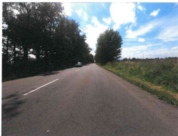
Ztráta makrotextury, mozaikové trhliny
