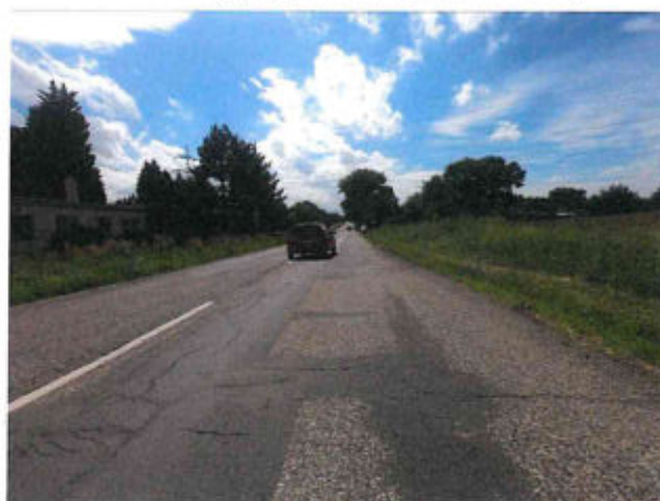
Ztráta mikrotextury, mozaikové trhliny, vysprávky
