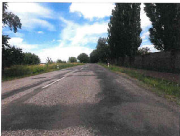
Ztráta mikrotextury, mozaikové trhliny, vysprávký
