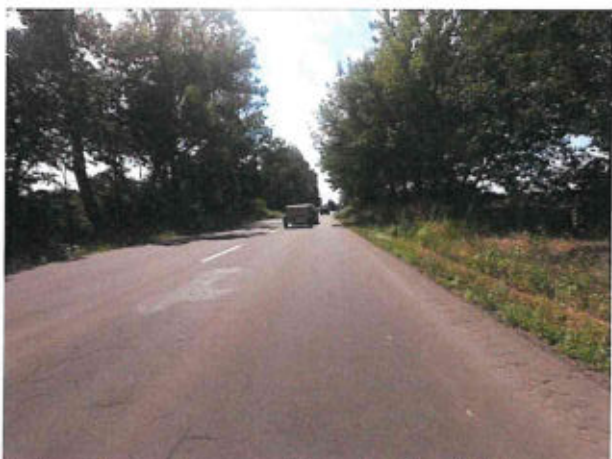
Ztráta makrotextury, vysprávka, mozaikové trhliny
