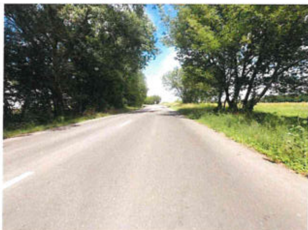
Ztráta makrotextury, vyjeté koleje
