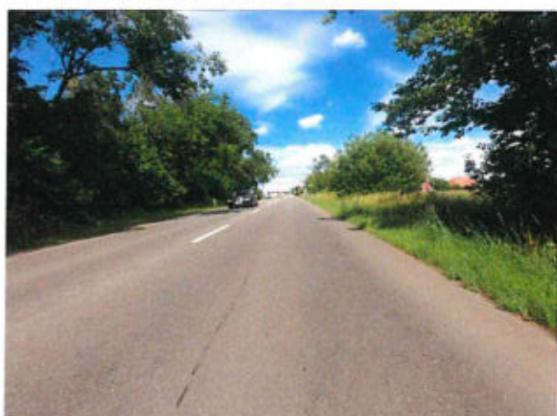
Ztráta makrotextury, vyjeté koleje
