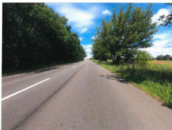
Ztráta makrotextury, vyjeté koleje
