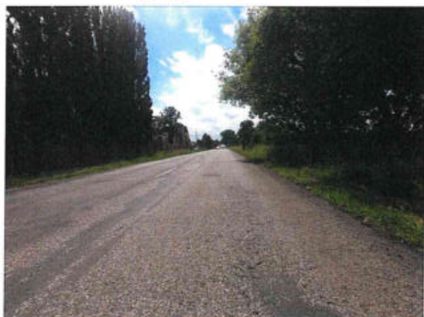
Ztráta mikrotextury, mozaikové trhliny, vysprávky
