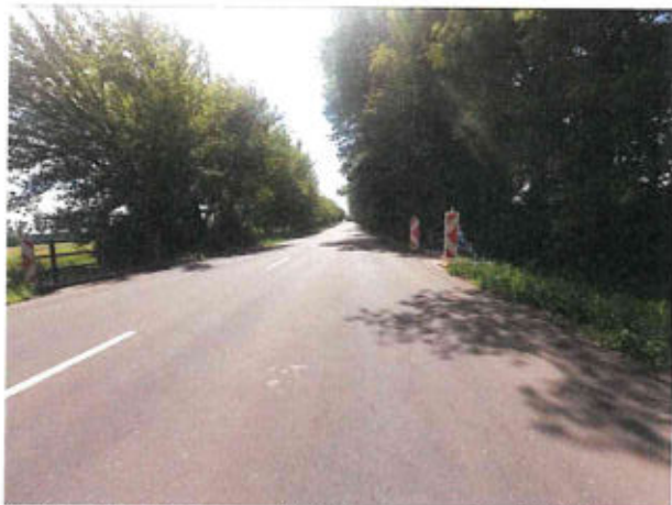
Ztráta makrotextury, vyjeté koleje, mozaikové trhliny
