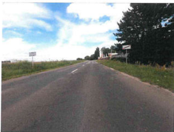
Mozaikové trhliny, vysprávký, vyjeté koleje
