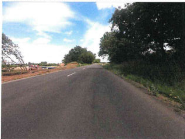
Ztráta makrotextury, vyjeté koleje
